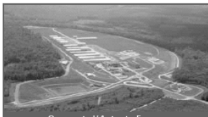
Centre de L'Aube in France
